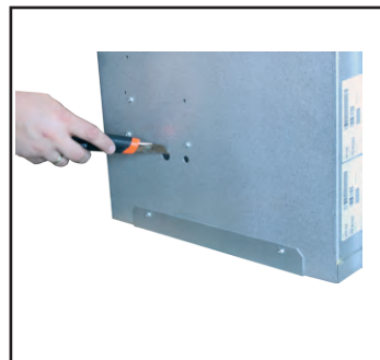
3. Auf der Rückseite bei der 16mm-Bohrung mit einem Messer die Isolierschicht durchtrennen.
