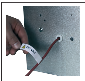
8. Abschließend die Anschlußleitung des Kondensatverdunsters mit einem Hinweis zur erforderlichen Netzspannung versehen und die Haube montieren.
